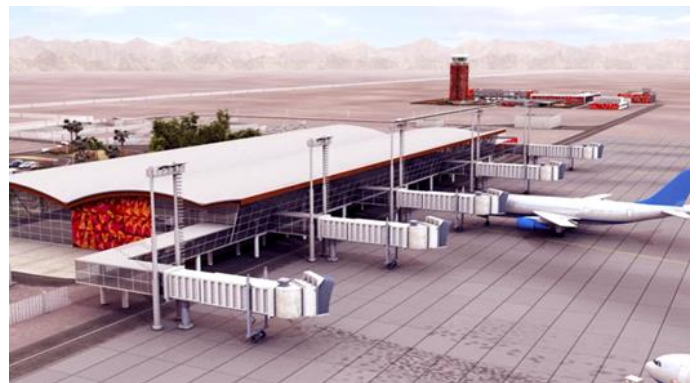
Vista del aeropuerto de Chacalluta actual
