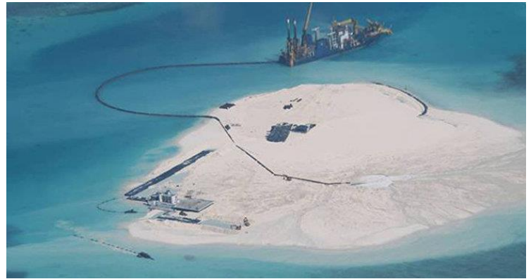
Figura 2: Proceso de relleno de islotes y construcción de aeródromos chinos. Fuente: BBC
