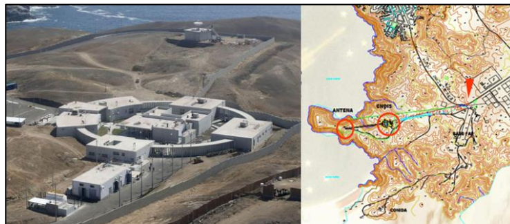
Foto Izq.: Instalaciones del CNOIS en Punta Lobos, Pucusana. Se observan los edificios de recepción y procesamiento de imágenes y al fondo, la antena bi-banda del proyecto. Gráfico Der.: Plano de ubicación de las instalaciones. Fuente: CONIDA.
