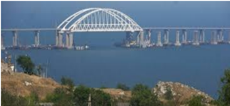
Figura 3: Puente sobre el Estrecho de Kerch. Se aprecia que la estructura limita el tipo de buques que pueden cruzar. Fuente: El País.com
